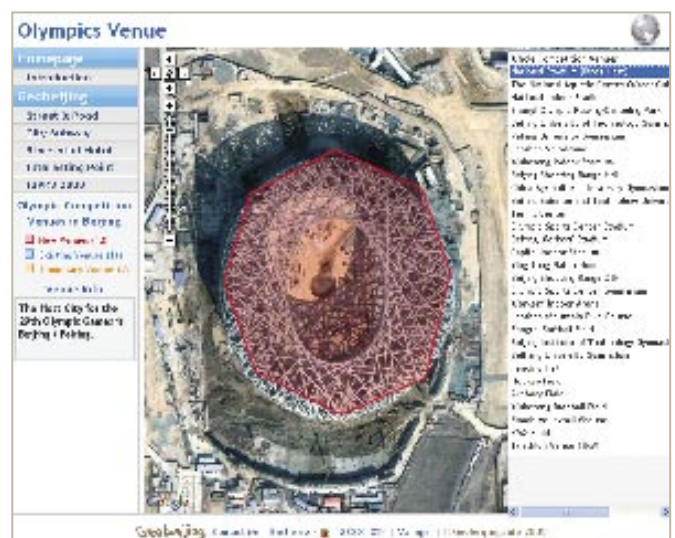
Nationalstadium - deutlich erkennbar der Zustand als Baustellen zum Zeitpunkt der Aufnahmen.
